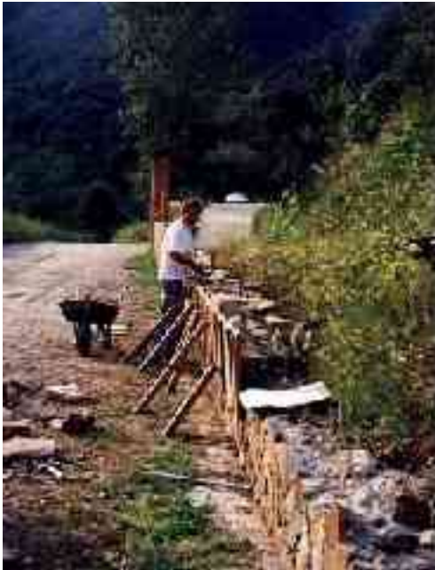
Fig. 16 – Jordi coloca piedras para el nuevo muro perimetral contra la carretera durante la primavera de 1998 mientras se iniciaba la ejecución para el cambio de cubierta en el edificio superior "A". En la fotografía se destaca la rica vegetación que rodea al operador . En esas épocas se intervenía con entusiasmo en los espacios verdes y estructuras mientras se negociaba la compra del inmueble sin grandes ilusiones puestas en el futuro.
