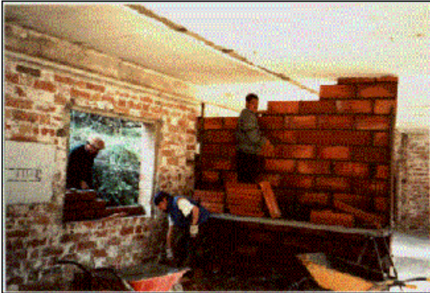
Fig. 33 – La planta baja esponjada y sin revestimientos interiores, recibe los primeros tabiques en 1999, mientras se cierran las aberturas en el sector destinado a las nuevos espacios de cocina.
