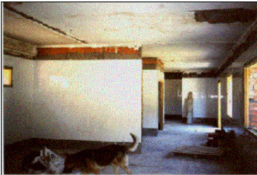
Fig. 34 – Desde la misma perspectiva, los espacios de cocina a finales del año 99, cuando se iniciaran las actividades para la primera edición del Taller de Ocupación “Osor I “. Cabe destacarse la ausencia de cielorraso y solados como de instalaciones eléctricas o de fontanería.
