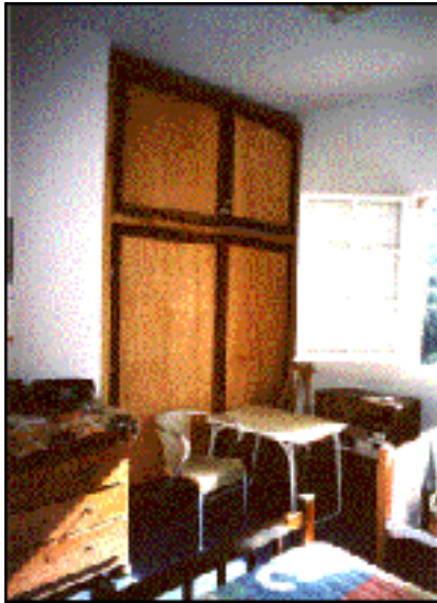
Fig. 47 – (Izquierda) Habitación de la cuarta planta (colectivizada) después de su rehabilitación de 1998. Este espacio social fue modificado por la inversión en materiales realizada con la subvención 0,54% al IRPF del Ministerio de Trabajo y Asuntos Sociales y el aporte de materiales cerámicos de la empresa Zirconio SA. La fotografía fue tomada en invierno y se destaca el hecho de la ventana abierta con importante entrada de sol.
