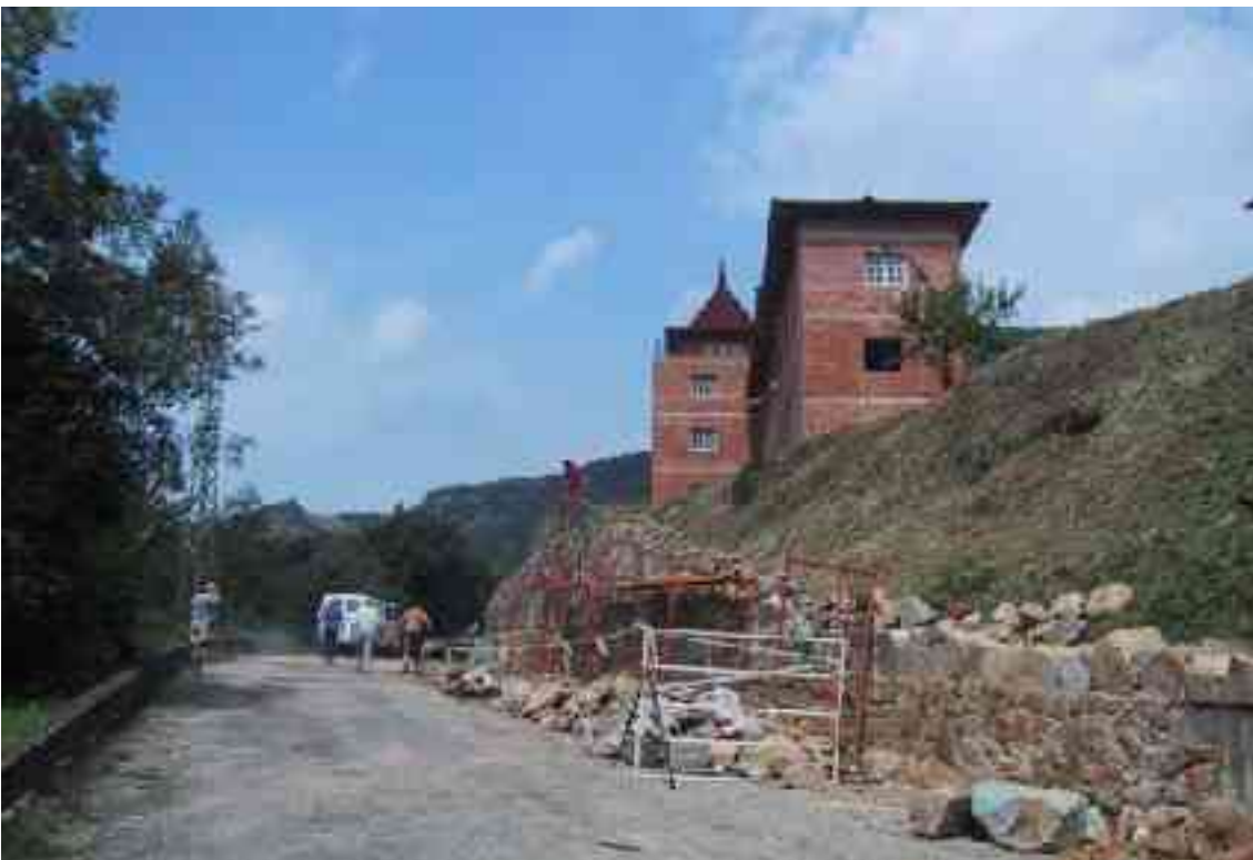
Fig.53 – (Arriba) Inicio de la construcción del muro perimetral sobre la carretera hacia el Este (200 metros lineales por 3,5 metros de altura) en septiembre del 2004.
