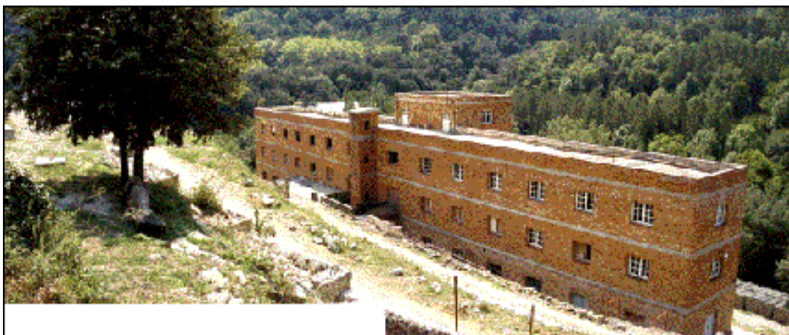
Fig. 51 – Imagen del Edificio Talleres (B) desde la necrópolis situada próxima a la ermita, antes de las intervenciones de reconstrucción y rehabilitación en el 2002-2003.
