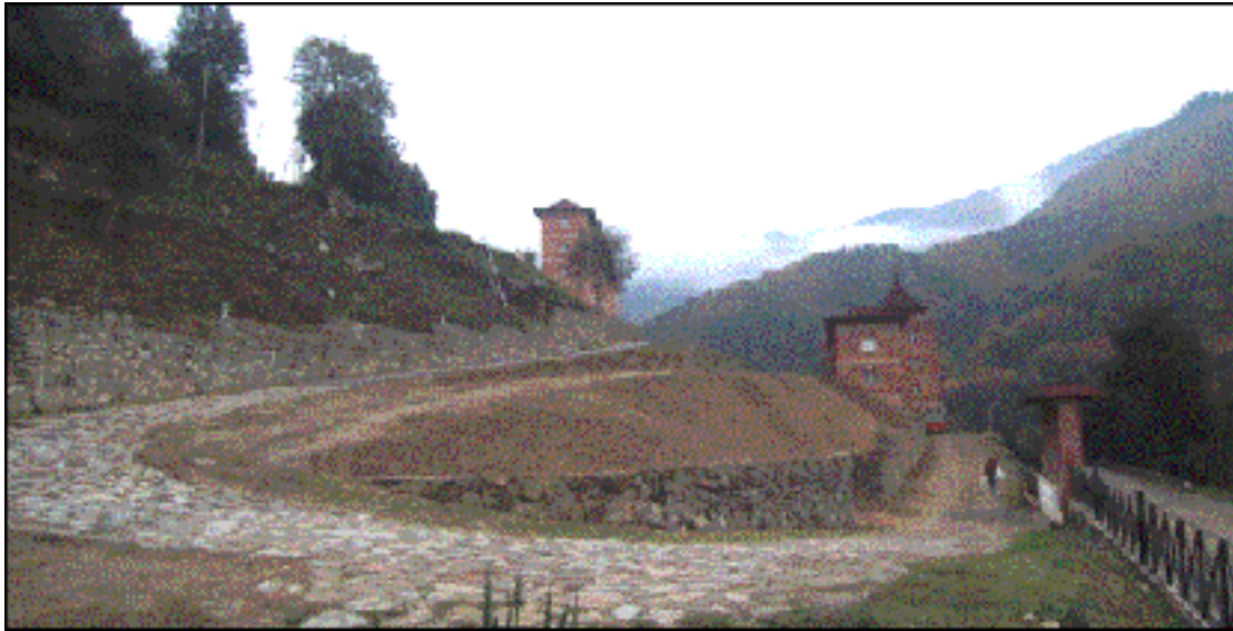
Fig. 45 – (Derecha) Inicio del enjardinado en el acceso principal (2003) y caminería de distribución desde el edificio “C”. Se destacan los dos edificios que no se veían en las primeras instantáneas realizadas hasta 1998.
