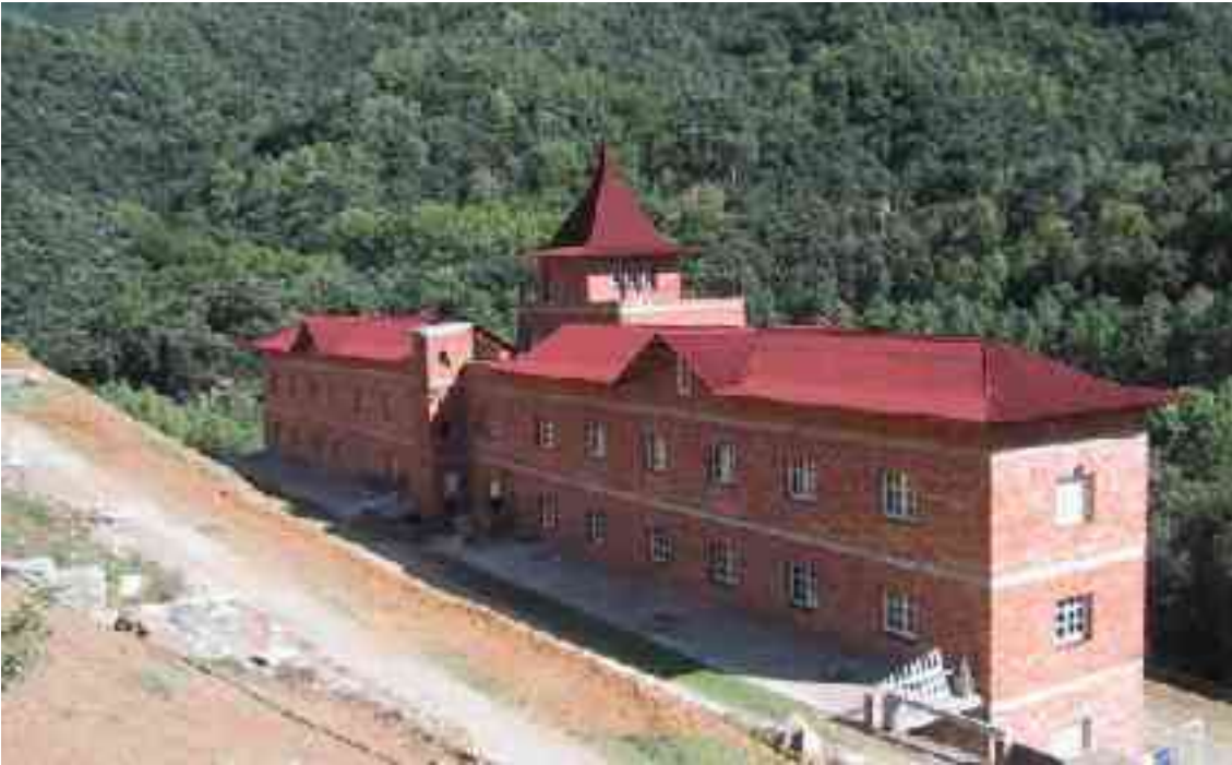
Fig.52 – Edificio B de talleres a finales de verano en el 2004 después de finalizadas las obras (dos ediciones de Talleres de Empleo).
