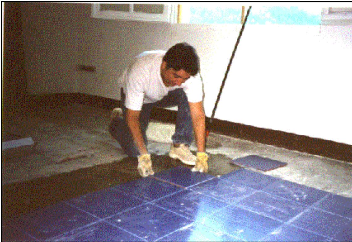
Fig.44 – Pedro coloca las baldosas cerámicas en los suelos de una de las habitaciones de la cuarta planta del edificio A (colectivizada) en 1998, después de finalizadas las obras de la cubierta.
