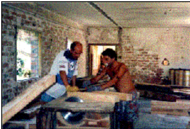
Fig. 5 – Fernando y “El Pescadilla” trabajan en el taller de soporte para las cubiertas en junio de 1988 utilizando el espacio anterior de la planta baja en donde ya se puede observar a la izquierda de la imagen el removido de todo el recubrimiento hasta llegar a los ladrillos.
