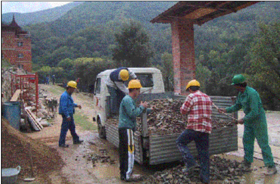
Fig. 49 – (Izquierda) Grupo de construcción baja grava para la caminería interior en Otoño del 2003.
