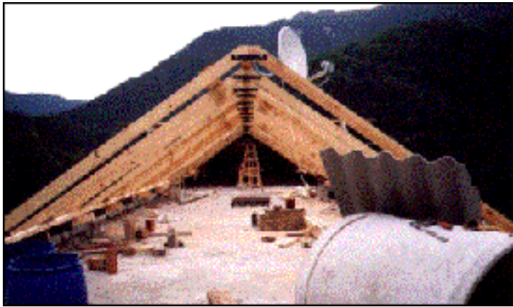
Fig. 17 – Costillares de “caballos” fijados a las paredes laterales del edificio “A” durante el verano de 1998. Las obras de los techos se iniciaron coincidiendo con visitas de interesados por la compra del inmueble.
