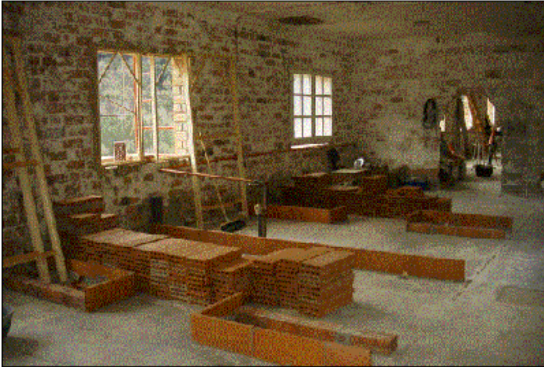
Fig.35 – Replanteo de habitaciones y baños en las plantas 1-2-3 del edificio “A”, una vez esponjado el edificio y en rectificación las aberturas correspondientes a los servicios.
