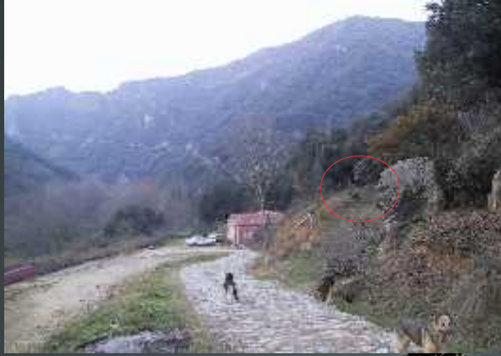
Camino de acceso a los vecinos con barra de paso antes de muros.
